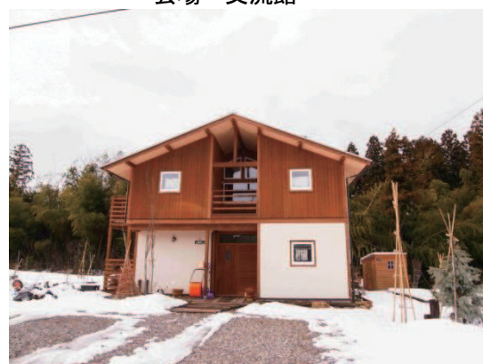
フィールド内の木造建物
