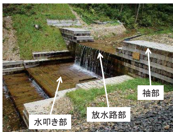
図1 木製治山ダム
