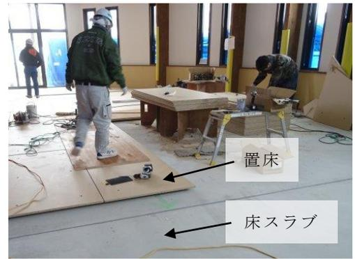
写真4 床下地の施工状況
