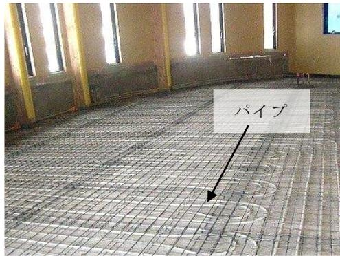
写真3 床暖冷房用パイプの敷設
