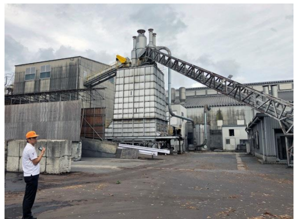
バイオマス利用セミナー 松江エヌエル工業発電所：焼却設備外観
