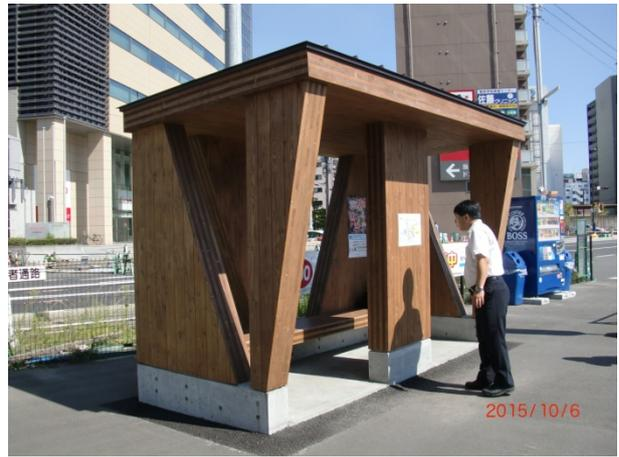
写真6 CLT を用いたバス停留所待合室
