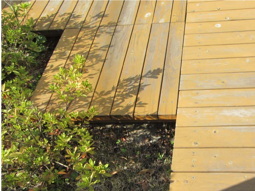
写真1 施工後2年を経たエコアコールウッド（九州木材株式会社）の屋外デッキ
