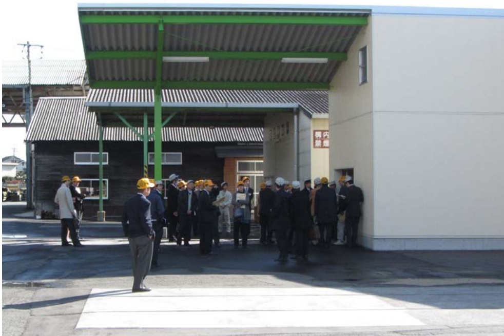
写真2 エコアコール注入設備の外観（九州木材株式会社）
