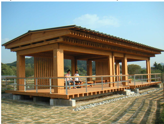
門型フレーム (高さ 2.72m、スパン 4.85m)
