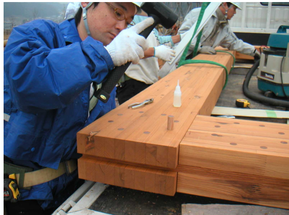
図 1 強化 LVL 接合と木質構造のシェルター
