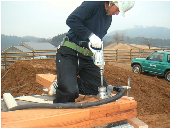
図 1 強化 LVL 接合と木質構造のシェルター
