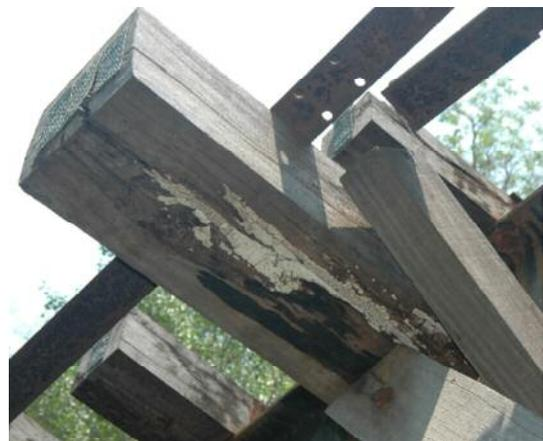
写真-6 床桁に見られた子実体
