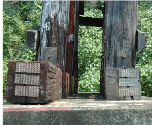
写真-5 腐朽によってつぶれた土台(右) 柱・金具が変形している(橋台No. 19)
