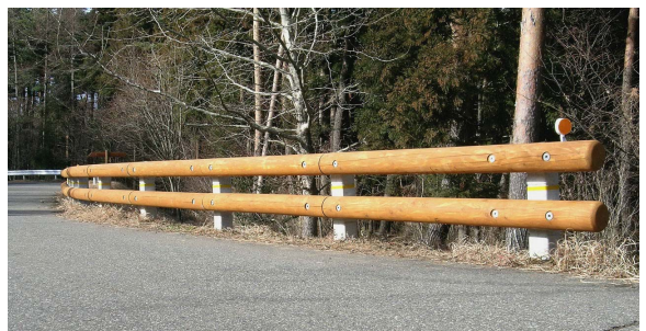
写真4 実車衝突試験に合格した 信州型木製ガードレール （上から1, 2, 3号型）
