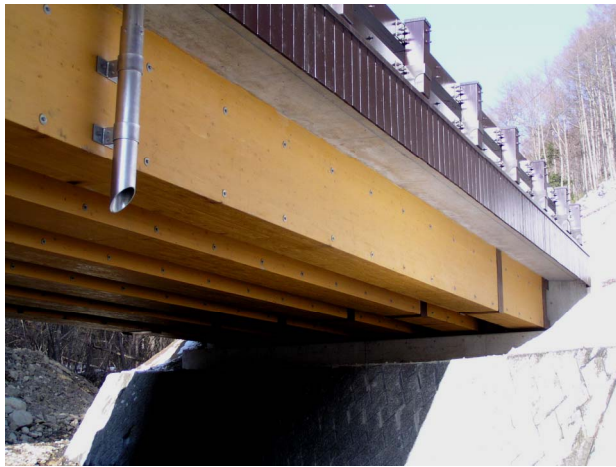
写真2 林道木橋（車道橋）の架設準備 [ 右上 ] と完成状態 [ 下2枚 ]
