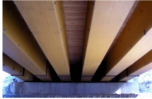
写真2 林道木橋（車道橋）の架設準備 [ 右上 ] と完成状態 [ 下2枚 ]
