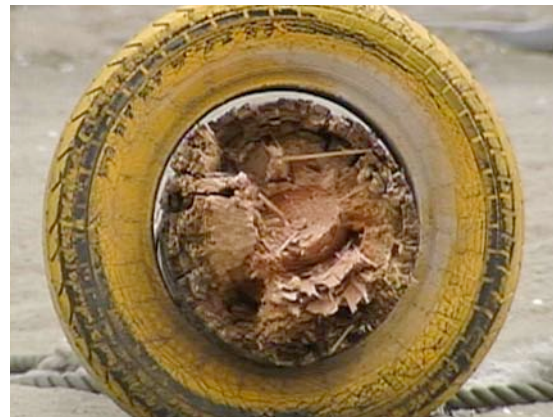
写真2 折れた支柱の切断面
