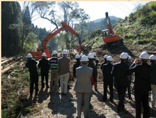
泉林業伐採現場
