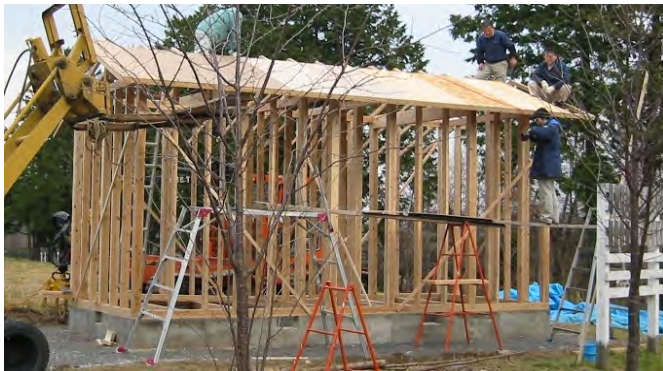
写真1 建築中の実験住宅
