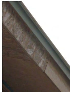
写真2 鼻隠しの施工状況
