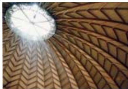
写真-5 左からカラムツ集成材によるドーム外観、内部、一般住宅用集成柱
