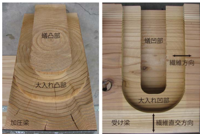
写真 2 在来「大入れ蟻掛けプレカット」仕口 左: 加圧梁凸部, 右: 受け梁凹部.
