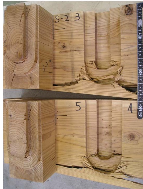
写真 3 在来仕口のせん断試験後の状況例
