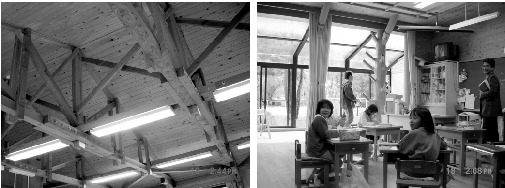
左：工作室のみは天井が施行されておらず、木製トラスが露出している。右：少人数で授業を受ける1年生。教室の南側はサンルームでヒノキの丸柱の1本は大枝が残されていて、子供たちの遊び場となっている。子供たちの表情が明るい。
