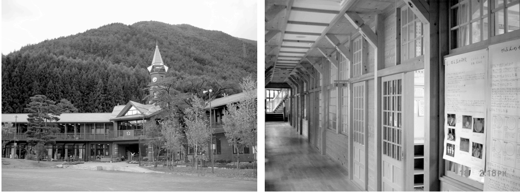
左：校舎外観、右：廊下。床、壁、天井の全てが木造で、暖かい雰囲気がある。教室と廊下は木製窓枠のガラス窓で、明るいが掲示物のスペースがないのが欠点とか。
