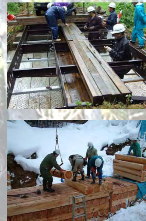
構造物の施工
