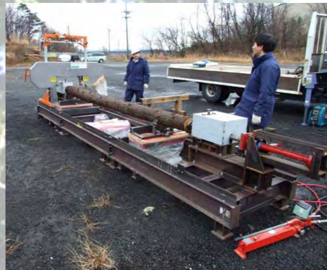
製材装置据付
