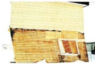
図 2.4.7 腐朽による地震被害(釧路沖) 内側に防湿層のある住宅で、1 階と 2 階の間の桁部分に結露腐朽が 集中した。このため、この部分 で折れ曲がるように壊れている (撮影:1993 年 1 月釧路町寒地住宅 都市研究所都市防災科)
