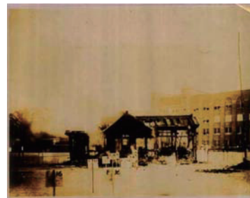
日本初の実物建物火災実験(東大構内、1933年8月)
