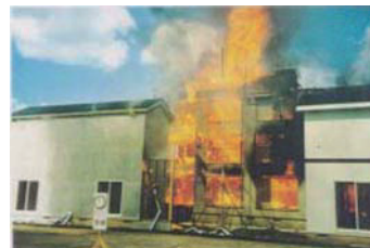
木造3階建共同住宅火災実験 点火後約3時間 (建設省建築研究所、1996)
