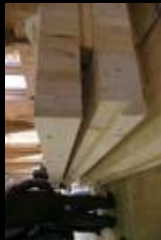
長ダボでラミナを積層したBrettstapel (Longin)
