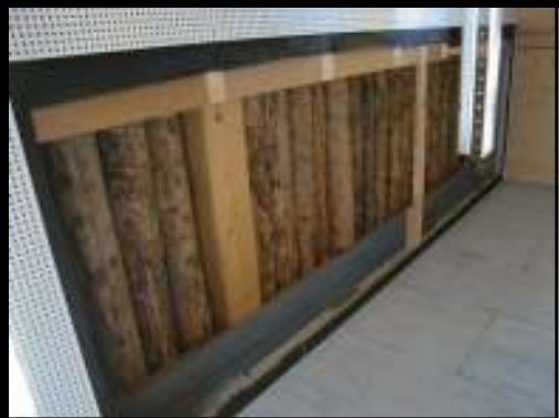
間伐丸太を利用したマツジブholz床版 (雪林学校 Lyss)
