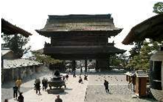
写真1 改修前（本堂より）
