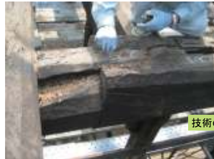
解体の様子（2006年8月）
