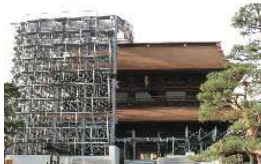
写真6 工事終了直前
