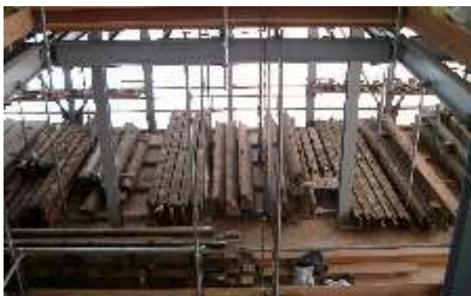
写真5 保管中の解体材
